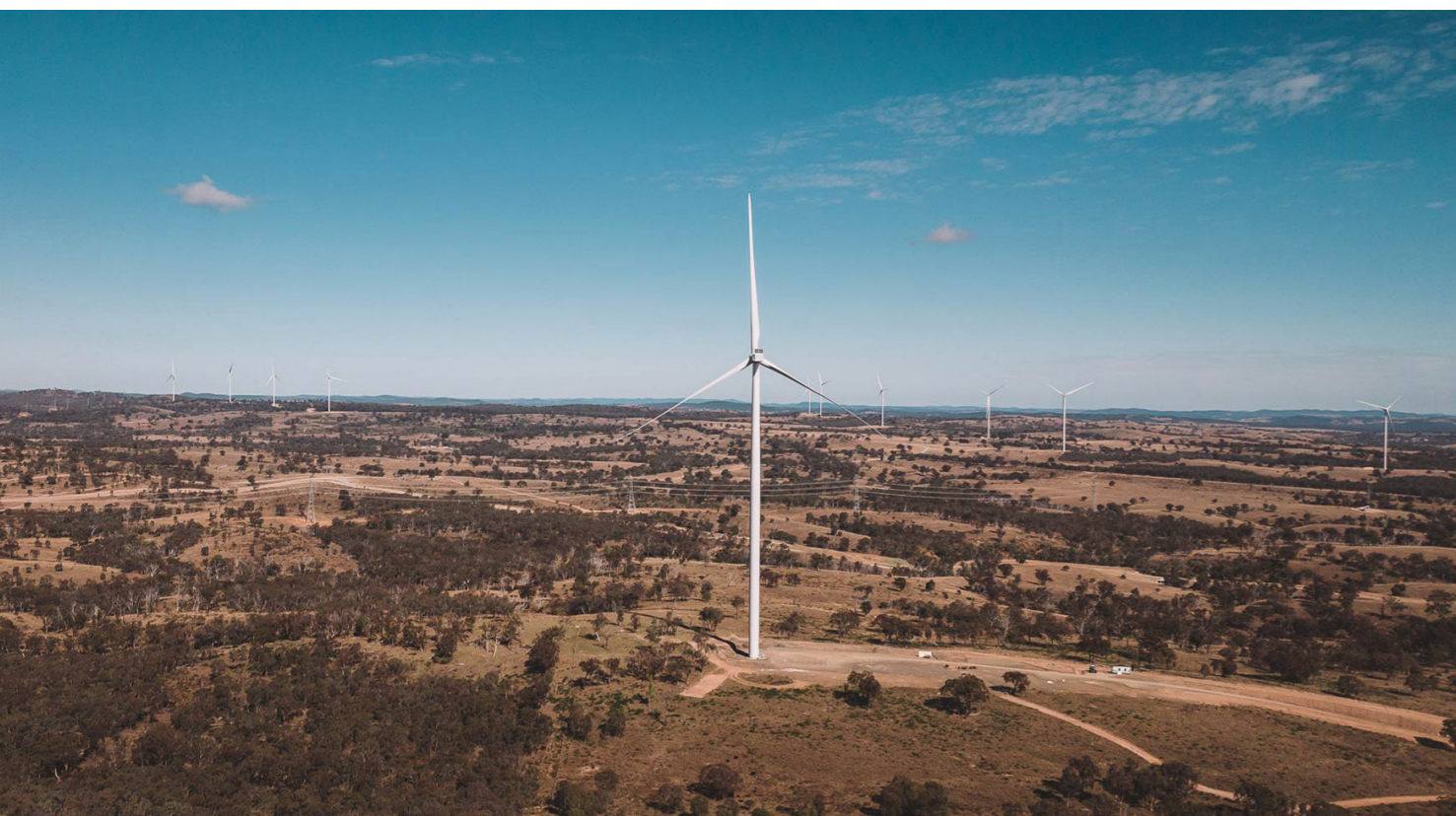
Parque eólico MacIntyre
